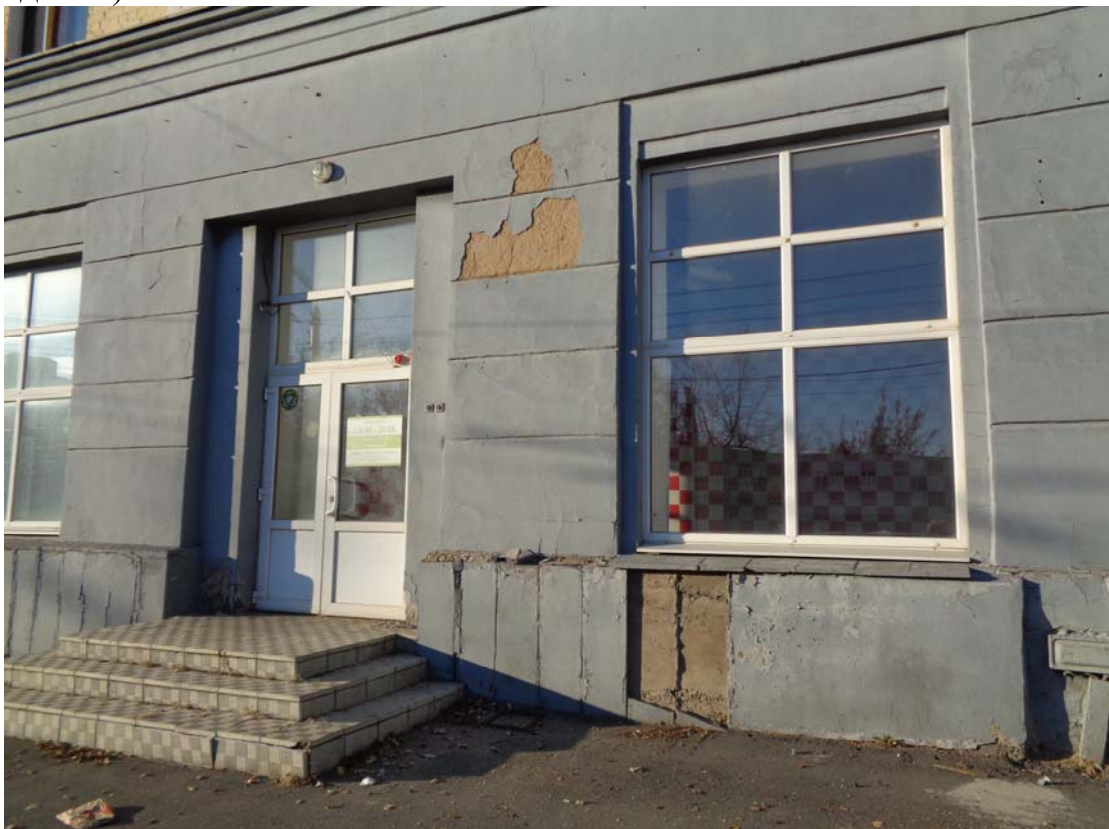
Фото 10. Фрагмент южного фасада здания: отслоившаяся краска; цоколь, облицованный базальтовыми плитами.
