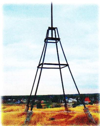
Геодезический пункт - инженерная конструкция, закрепляющая точку земной поверхности с определенными координатами.
